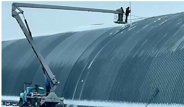
**Рис. 2 – Ручная очистка поверхности бескаркасных арочных зернохранилищ от снегового покрова**
